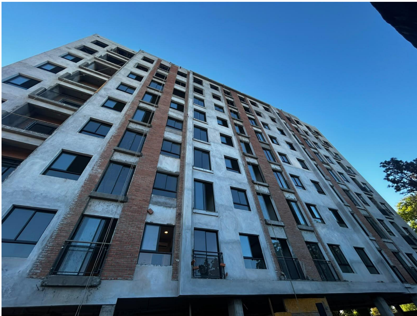
Avances en fachada posterior
